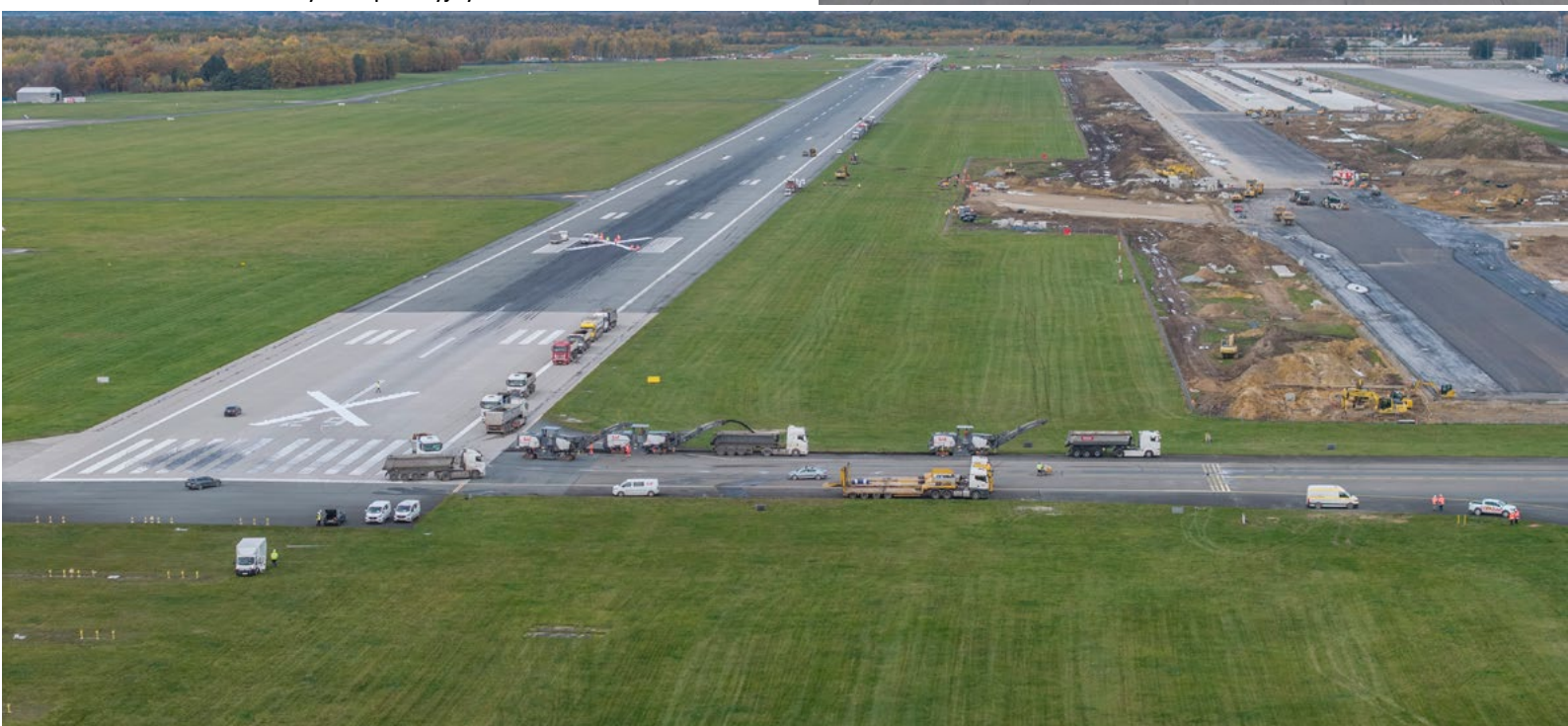
Fot. Prace przy rozbudowie infrastruktury lotniskowej po wstrzymaniu operacji lotniczych. © STRABAG
