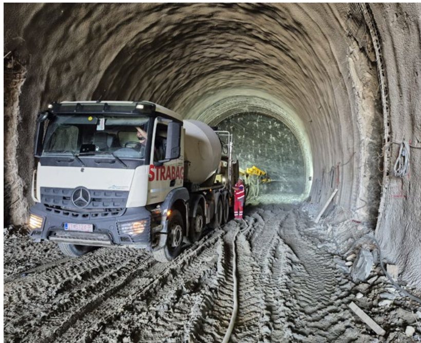
Fot. Prace przy budowie tunelu Gladnjici w Chorwacji. © STRABAG
