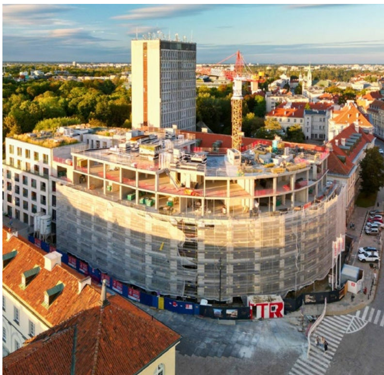
Fot. Villa Bogoria osiągnięta docelową wysokość. © STRABAG
