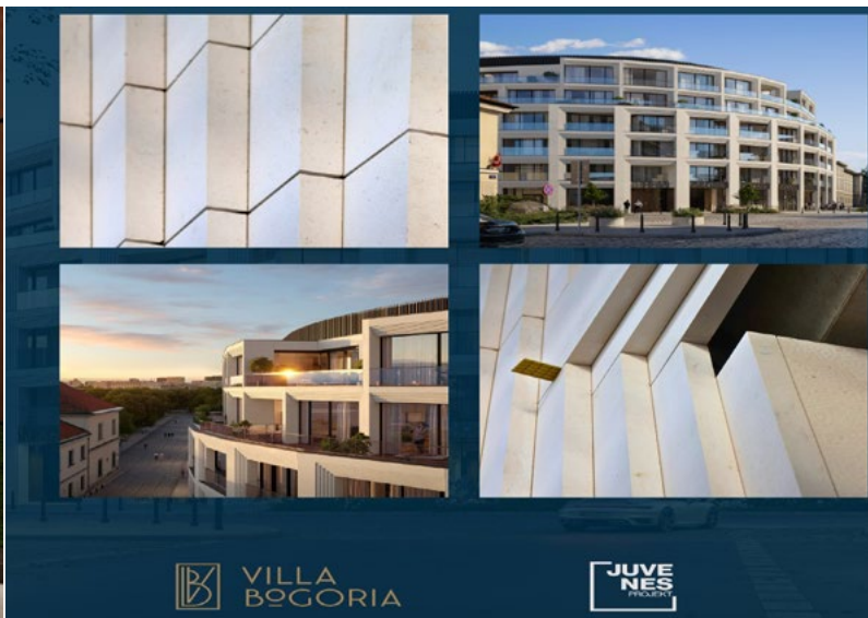
Wiz: Elewacja budynku z płyt Piedra Paloma. © JUVENTUS PROJEKT
