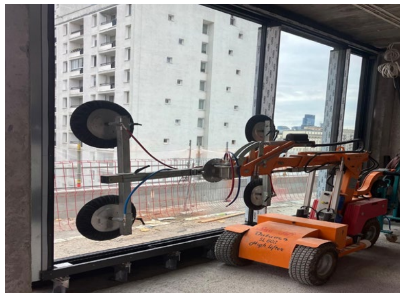
Fot: Montaż stolarki okiennej z wykorzystaniem automatycznego wózka. © STRABAG
