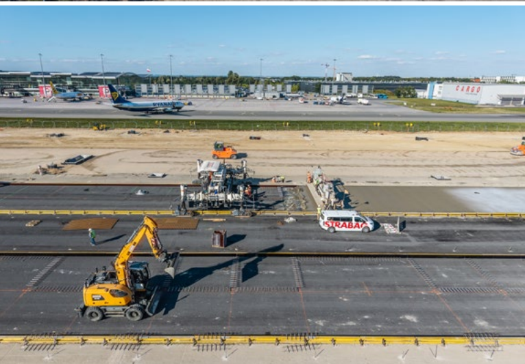
Fot. Prace przy rozbudowie infrastruktury lotniskowej. © STRABAG
