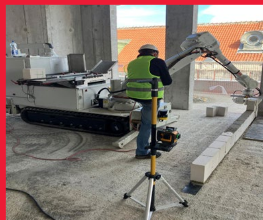
Fot. Robot murarski w trakcie pracy © STRABAG
